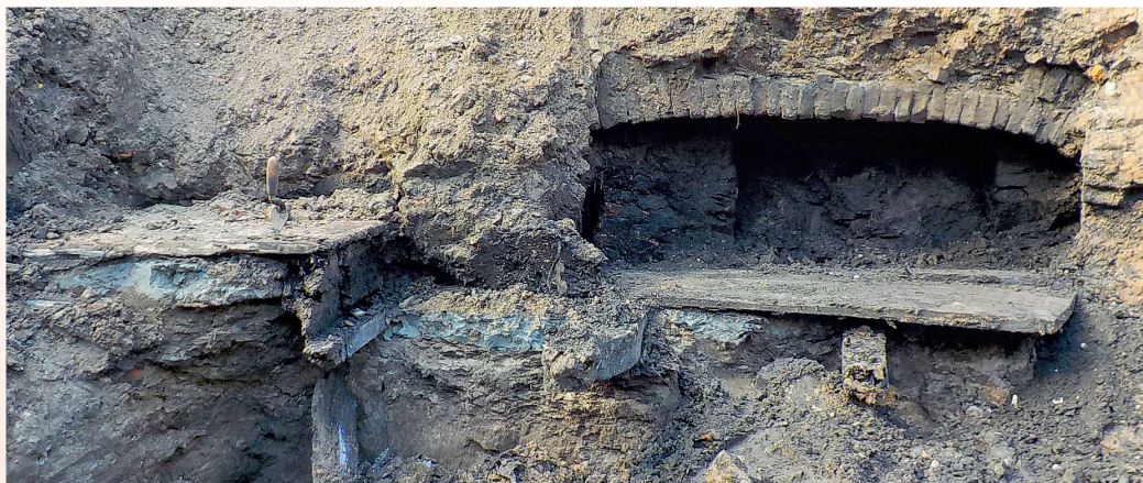
▲ Resten van de aan- en afvoergoot met duiker.
