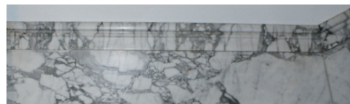
▲ Marmeren lambrisering in de vestibule (ruimte 0.01) op de bel-etage.
