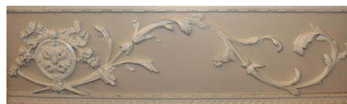
▲ Rijk gedecoreerde lambrisering in de chambre (ruimte 0.02) op de bel-etage.
