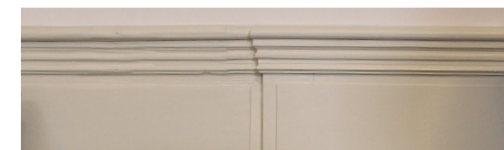
▲ Vlakke lambrisering in ruimte 2.01 op de tweede etage.
