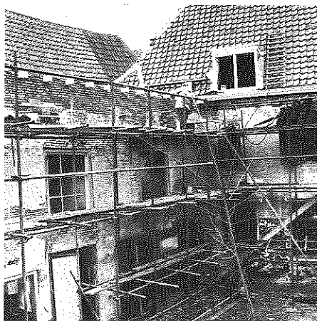
Restauratie Grote Spui, achterzijde (januari 1977)
