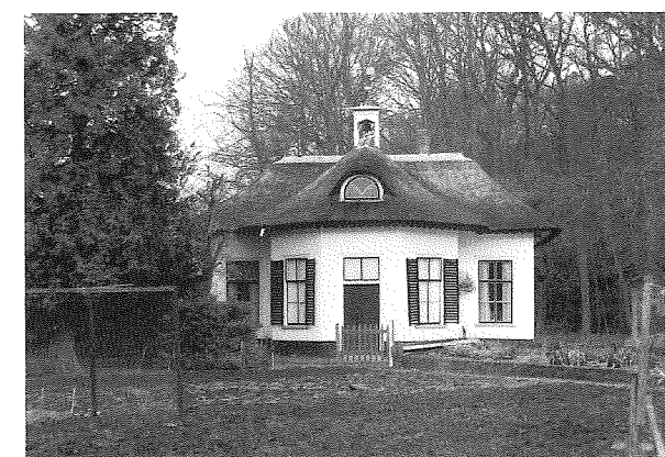
13. De tuinmanswoning in de moestuin, vermoedelijk gebouwd tussen 1807 en 1827.
