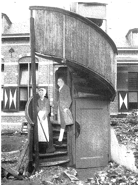
Een van de trappen in het regentenhuis tijdens de afbraak. Zie ook de tekening van Grolman van de hal met deze trap. Op de achtergrond de nieuwbouw, die dan net gereed gekomen is.
