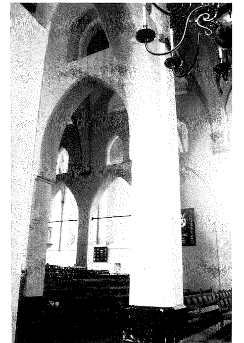
4. Het middenschip. Door de meest oostelijke arcadeboog van de zuidmuur is de noordmuur zichtbaar met de dieldelige wandopbouw. De muur op de voorgrond is het restant van het dwarsschip.
