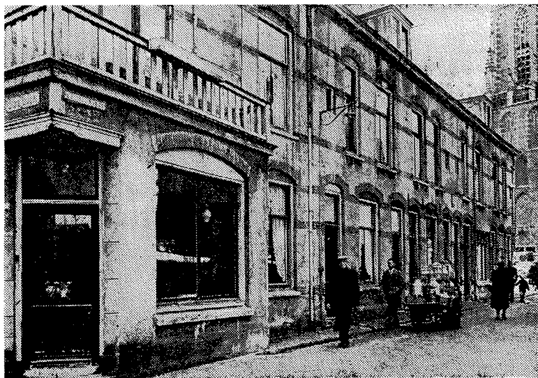
De Zwanehalsteeg in 1955. Geheel links de winkel op de hoek van de Langegracht, daarnaast de in 1905 gebouwde boven- en benedenwoningen, (Amersfoortse Courant 27 april 1955).
