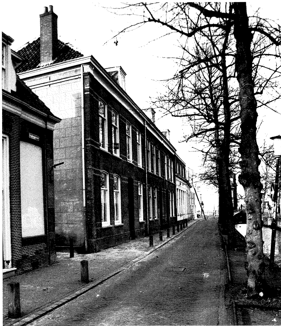
Hoek Kortegracht-Drieringensteeg, recente opname.
