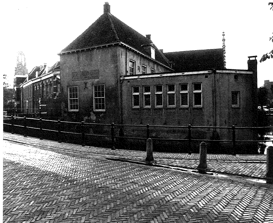
Het 'zaaltje' van de R.K. Spaarbank, gebouwd in 1923 naar ontwerp van de architect G. Adriaans. Deze aanbouw werd bij de laatste restauratie afgebroken.
