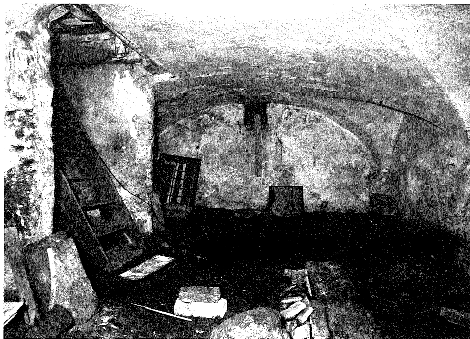
De kelder (C), met tongewelf en drie steekgewelfjes, onder Breestraat 80, voor de restauratie.
