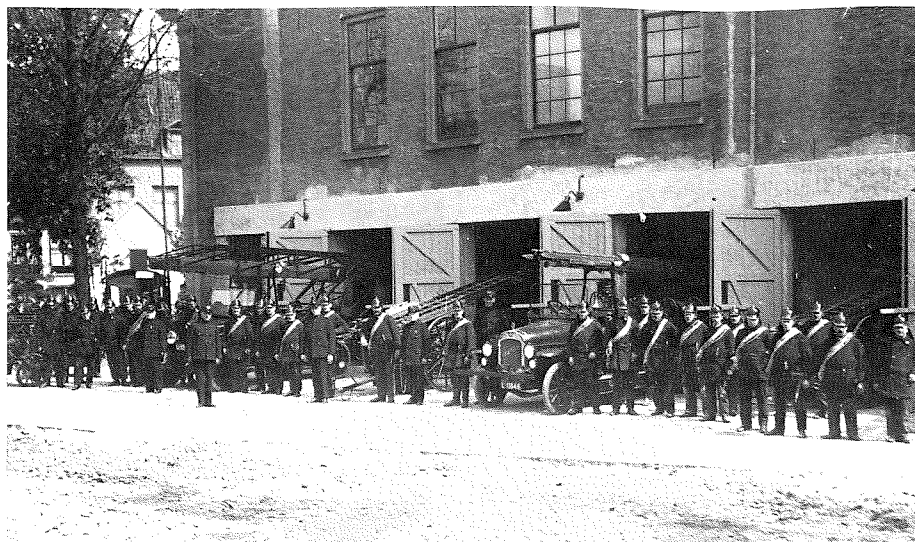
Het Observantenklooster als brandweerkazerne.
