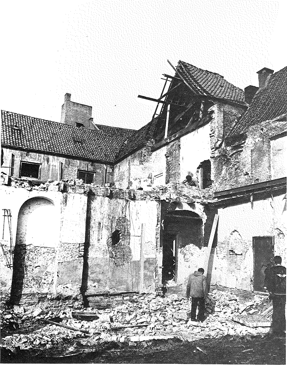
Het vrijmaken van de te restaureren gedeelten rond de binnenplaats (de afgebroken vleugel B).
