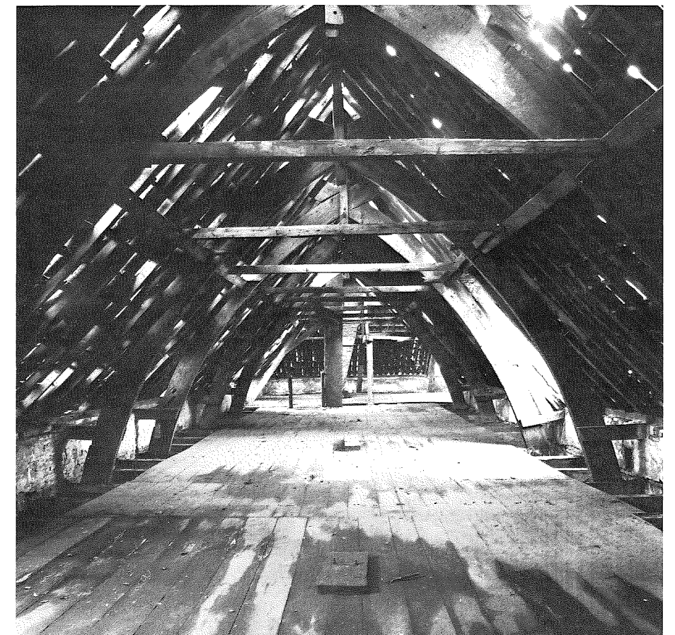
Zolder van de thans verdwenen vleugel. Op deze plek is thans de kloosterhof gereconstrueerd.
