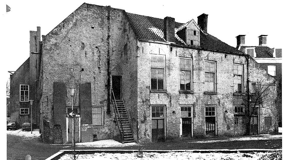
Westgevel van het Observantenklooster, voor de restauratie.
