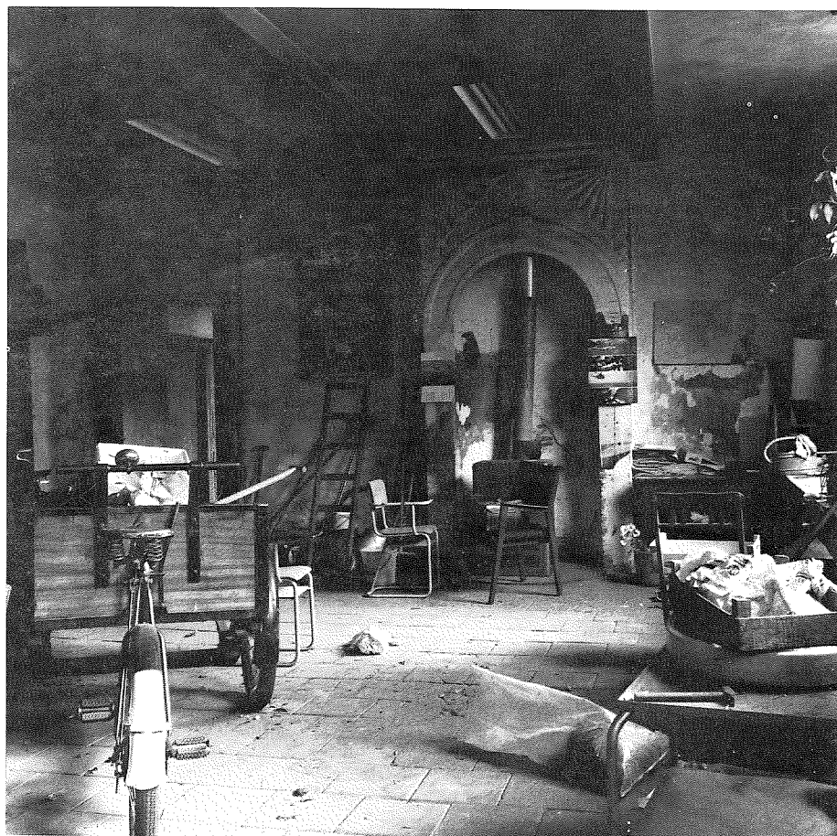
Westvleugel, begane grond.
