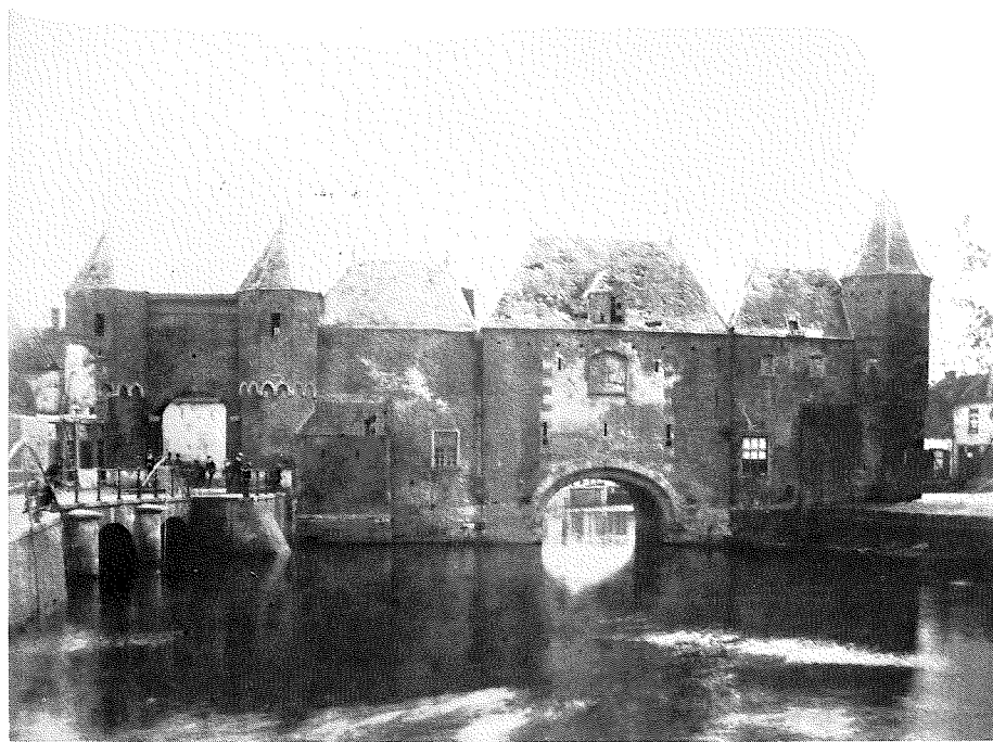
De Koppelpoort bij het begin van de restauratie (april 1886). Uiterst links is men reeds begonnen met de afbraak van het pand tussen de poort en de volmolen. Boven de waterpoort het wapenbord. Heel duidelijk is de desolate toestand van de daken te zien.
