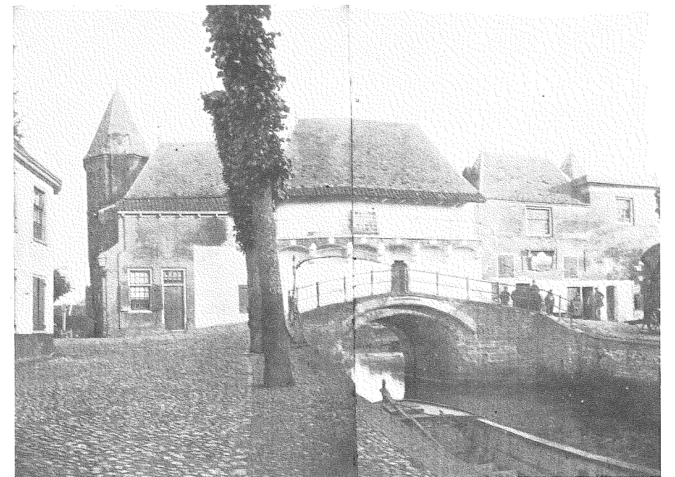
De Koppelpoort in 1864. De bouwsels op de eerste verdieping rechts van de waterpoort verdwenen bij de restauratie. De open gaanderij werd aan de linkerzijde voortgezet.
