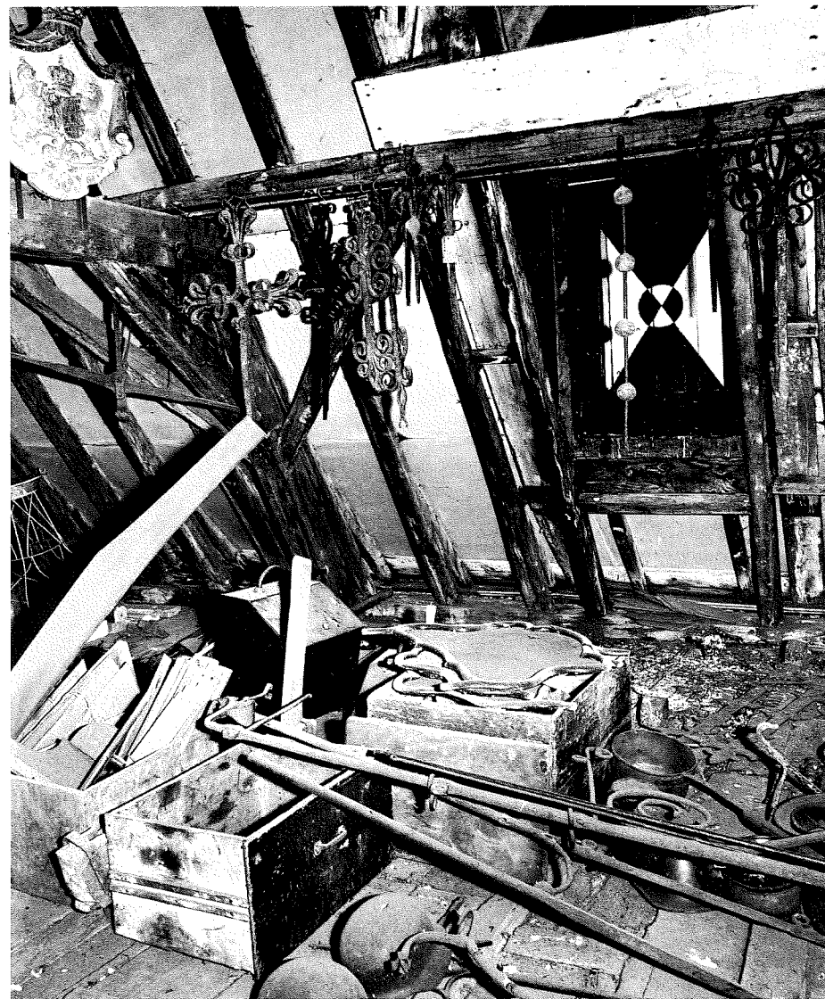
Een kijkje op de zolder van Breestraat 78. Vóór de verbouwing van 1978/79!
