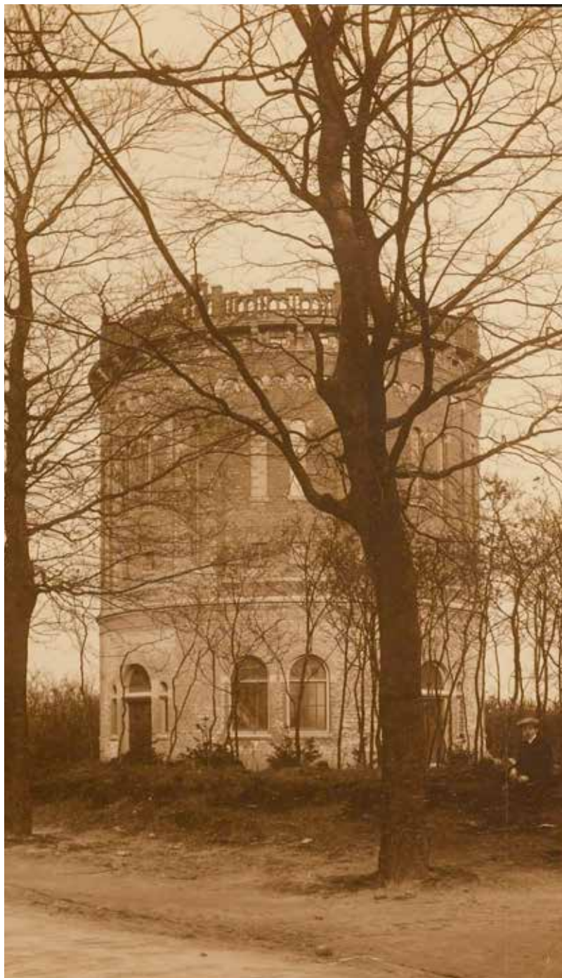
De watertoren tijdens de bouw (linksboven) en na oplevering.
