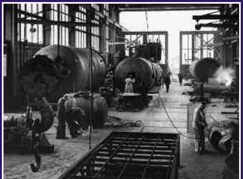
Mensen aan het werk bij de ketelbouw van Bronswerk (AMAF), in het complex aan de Brabantsestraat en de Eem. Via de open deuren aan het einde van de hal werd de ketel op transport gesteld. Circa 1960.
