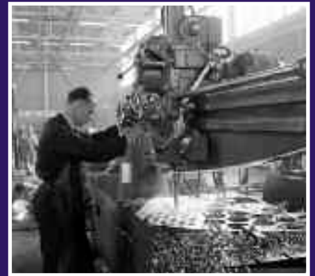
Metaalbewerking in de hal van Bronswerk/AMAF. Ze maakten hier toestellen voor verwarming, ventilatie en luchtbehandeling en ook pijpleidingen. 1955. © Cas Oorthuys/Nederlands Fotomuseum.
