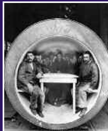
Fabrieksarbeiders van Huygen & Wessel poseren in een eigen werkstuk. Deze fabriek stond aan de Eemstraat, hoek Nijverheidsweg. Ze maakten verwarming voor villa's, scholen en andere grote gebouwen. Met hun fornuizen kon je niet alleen koken, maar ook je woning en badwater verwarmen. Circa 1930.
