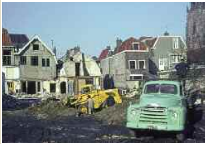
'Bulldozers in actie' aan Achter de Arnhemse Poortwal. De panden Utrechtsestraat 14 t/m 24 werden gesloopt. Hier zou vervolgens de Hema worden gebouwd. Februari 1964.
