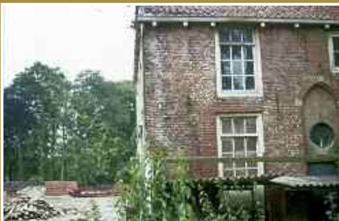
De zuid-oostvleugel van het voormalige Observantenklooster, gezien naar Plantsoen West en de Begraafplaats Achter Davidshof. We zien hier bouw materiaal klaarliggen voor het nieuwe stadhuis. 1972.
