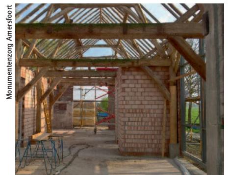
Transformatie van tabaksschuur tot woning.
