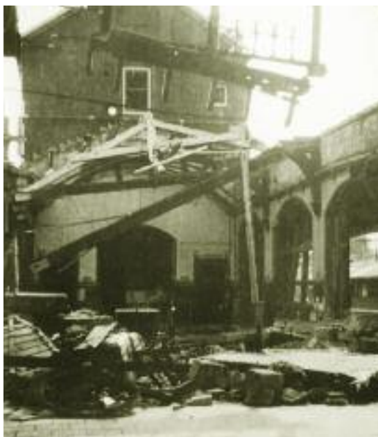
Het verwoeste station Amersfoort, februari 1945 (Archief Eemland).
