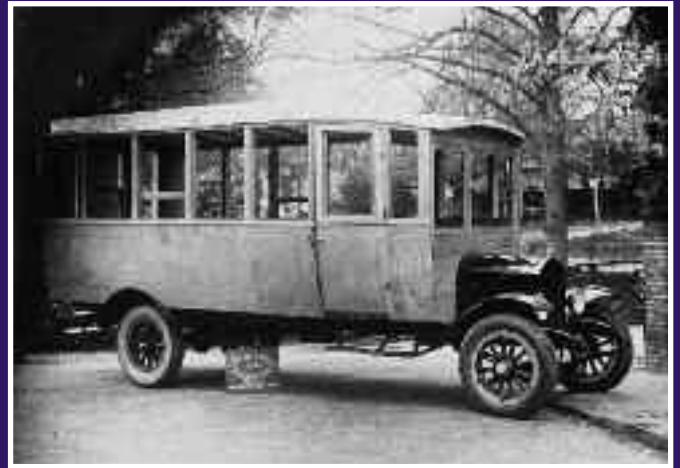
Een primitieve autobus, gebouwd op een Ford-chassis. Ford leverde geen specifieke autobuschassis, reden waarom voor dit doel bestel- of vrachtwagenchassis werden gebruikt. Deze en de volgende foto's zijn genomen in de Korte Beekstraat, vóór het huis van fotograaf Van de Pol. Circa 1925-1930.
