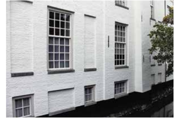
▲ Westgevel van Huis Cohen, souterrain en bel-etage.
