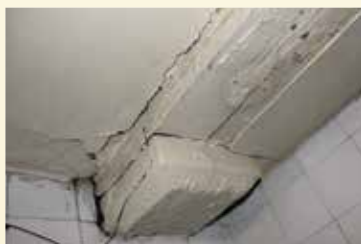
▼ 17e-eeuwse ongeprofileerde vloerbalk van de bel-etage met eenvoudig sleutelstuk (ruimte -1.03).
