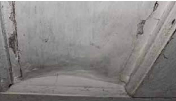
▲ Troggewelf in het souterrain onder de marmeren vloer van de hal op de bel-etage. De balkranden zijn voorzien van een 18e-eeuws duivejagerprofiel.
