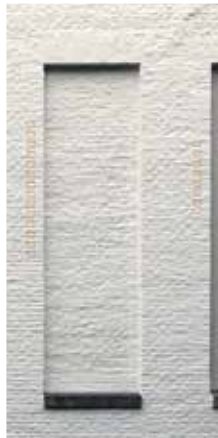
▲ Detailopname van metselwerk en blindnis in de zijgevel. Enkele van de klezoren in het 17e-eeuwse metselwerk zijn rood omlijnd.
