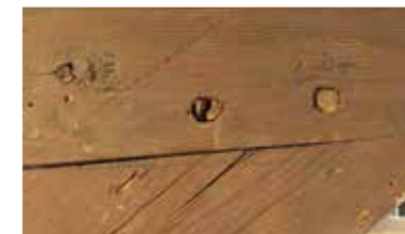
▲ Ingekraste constructielijnen rond de aansluiting van dekbank en korbeel op de dekbank van een halfspant.
