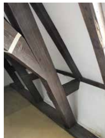
▲ De kreupele staander rust op een parallel aan de gevel geplaatste slof en is middels een blokkeel (zie de schets van de halfspanten) aan de borstwering verbonden. Op de borstwering ligt de muurplaat.
