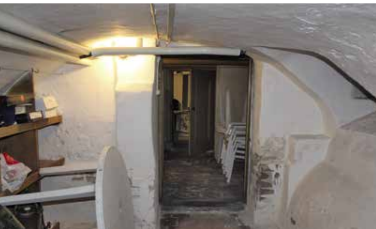
▲ Troggewelf in het souterrain onder de marmeren vloer van de hal op de bel-etage. De balkranden zijn voorzien van een 18e-eeuws duivejagerprofiel.
