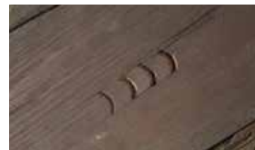
▲ Telmerk IIII, met een guts aangebracht op een korbeel bij de achtergevel.
