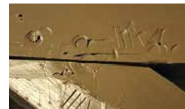
▲ Telmerk VIII, met een rechte beitel aangebracht op korbeel en spantbalk van een van de halfspanten bij de voorgevel.
