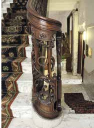
▲ Balustrade en baluster op het draaipunt van de trap bij het bordes.
