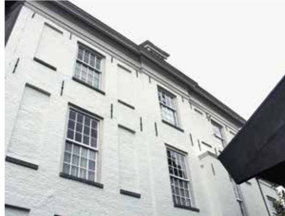
▲ Westgevel van Huis Cohen, eerste en tweede etage.
