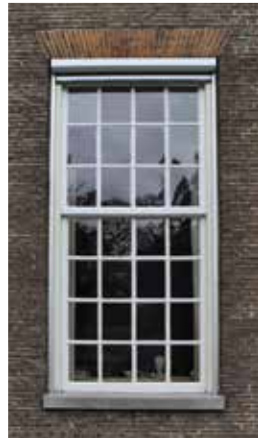
▲ 17e-eeuws venster met een 18e-eeuws raam in de achtergevel (bel-etage). De strekse boog boven het venster is uitgevoerd in zachtere (rodere) baksteen.
