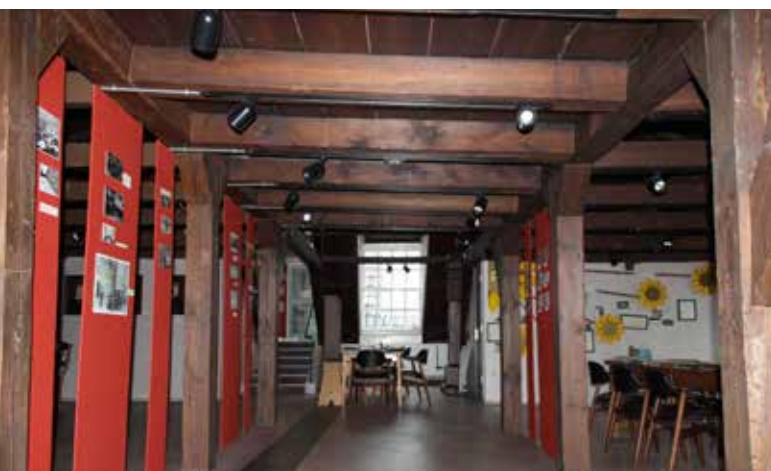
◀ Overzichtopname van de zolder met links en rechts bovenaan de twee schaargebinten op standvinken. Tussen beide gebintbalken ligt het verlaagde loofhuttendak, gedragen door een aantal onderslagbalken.
