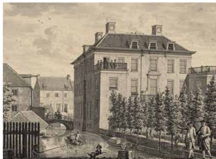
► Jordanus Hoorn, Gezicht op de achterzijde van het huis van B. Cohen te Amersfoort (provincie Utrecht), 1784 Collectie Museum Boijmans Van Beuningen, Rotterdam. Legaat: H.M. Montauban van Swijndregt 1929 / Creditline fotograaf: Studio Tromp, MvS 132 (PK)
