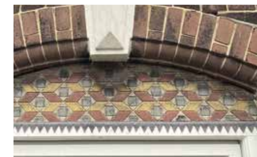
▲ Nicasiusstraat. Boven zoals het niet de bedoeling is: verlies van boogvulling en facetrand in kozijnhout, geen weldorpel en een ventilatierooster in het zicht. In overleg is tot de foto rechtsboven gekomen: veel klassiekere uitstraling met weldorpel, bewerking van kozijnrand en een niet zichtbare ventilatievoorziening direct boven het bovenraam. Foto rechts: met nog wat extra moeite is ook het karakteristieke geknipte lood boven het kozijn weer in ere hersteld.
