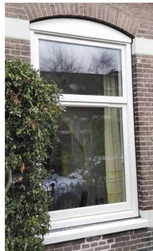
▲ Nicasiusstraat. Boven zoals het niet de bedoeling is: verlies van boogvulling en facetrand in kozijnhout, geen weldorpel en een ventilatierooster in het zicht. In overleg is tot de foto rechtsboven gekomen: veel klassiekere uitstraling met weldorpel, bewerking van kozijnrand en een niet zichtbare ventilatievoorziening direct boven het bovenraam. Foto rechts: met nog wat extra moeite is ook het karakteristieke geknipte lood boven het kozijn weer in ere hersteld.
