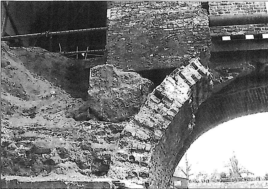
De herstelwerkzaamheden aan Monnikendam in 1997.
