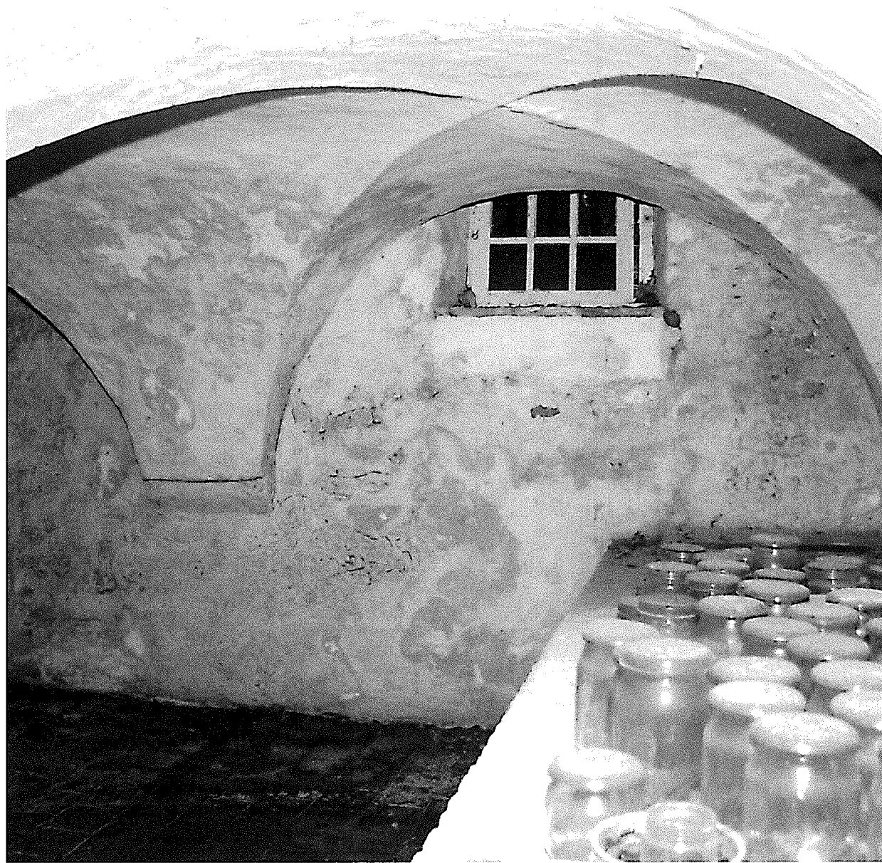
Verkleinde raamopening in de kelder onder de Celzusterenkamer.
