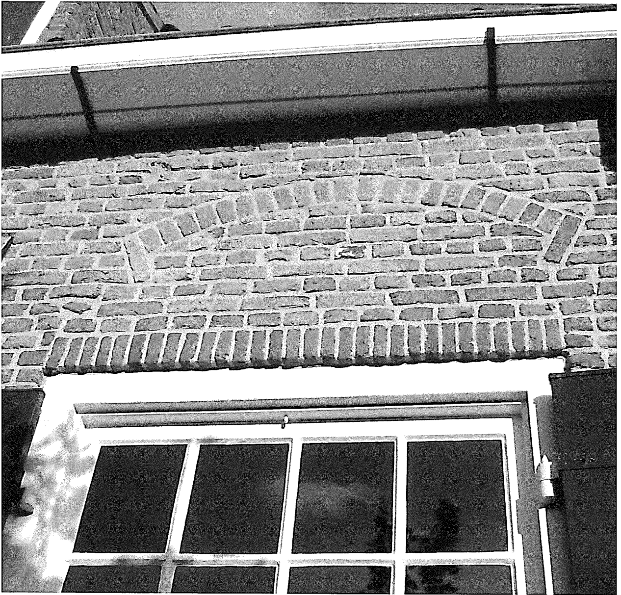
Segmentboog buiten de as van het venster aan de westzijde van de Bakkerij.
