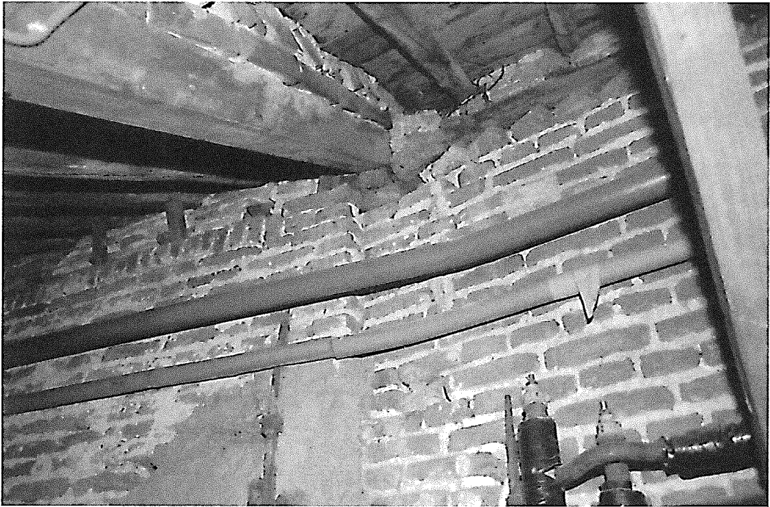
Aansluiting van het muurwerk van de Regentenkamer (links) op het oudere muurwerk van de Vestibule (rechts) in de voormalige oostgevel.
