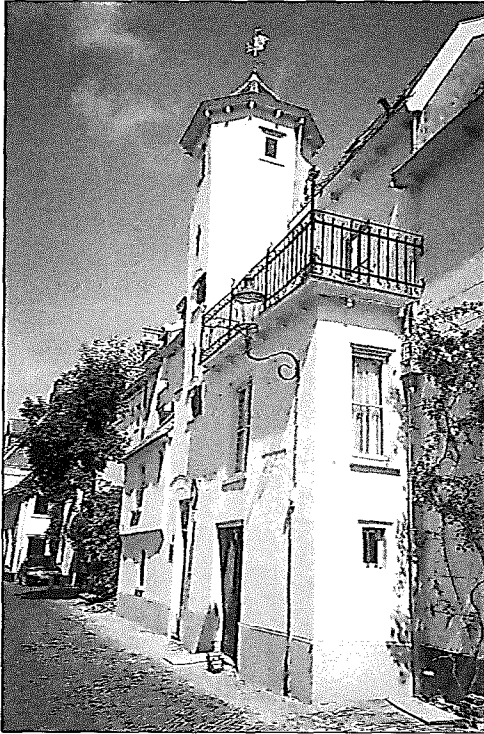
De gevel van Muurhuizen 33 na de restauratie.
