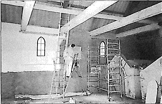
Interieur van de kapel van Koelhorst tijdens de restauratie van 2002-2003, als laatste handeling is de kapel van binnen en van buiten van een kleverige afwerking voorzien Foto Collectie Monumentenzorg.
