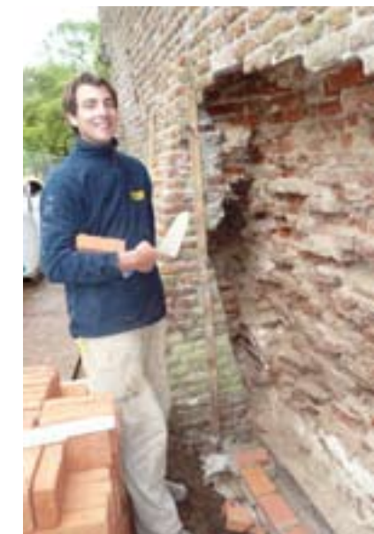
Op veel plaatsen was inboetwerk uit het verleden slecht met het oude werk verankerd. Metselaar Rob Kapteins staat klaar om dit probleem op te lossen.
