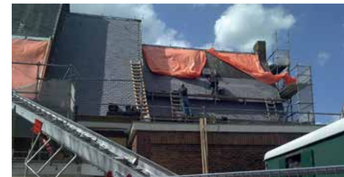
Leiwerk in uitvoering.
