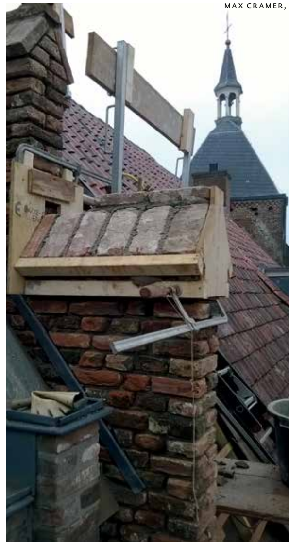
Herstel van de monumentale kappen.
