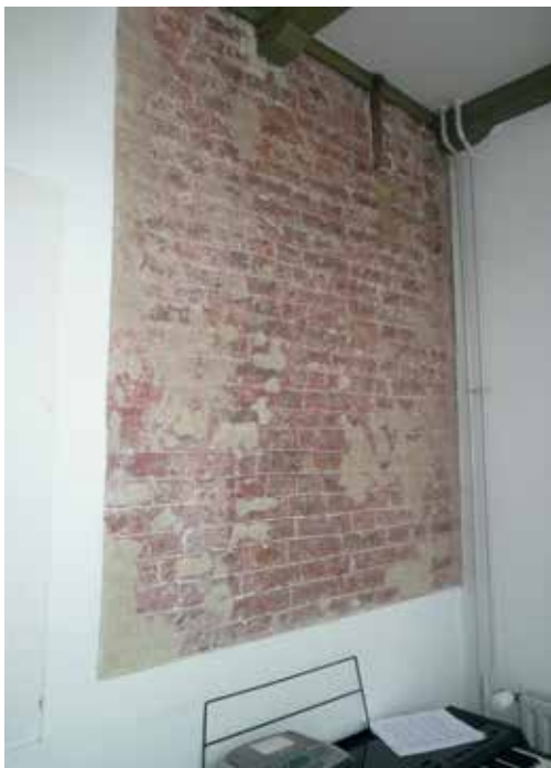
De middeleeuwse afwerking van de oorspronkelijk voorgevel met een metselwerkimitatie bevindt zich nu in het interieur van Muurhuizen 3.
