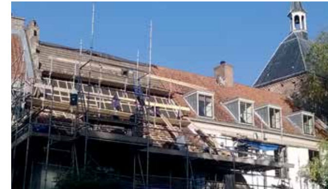
Herstel van de trapgevel.
