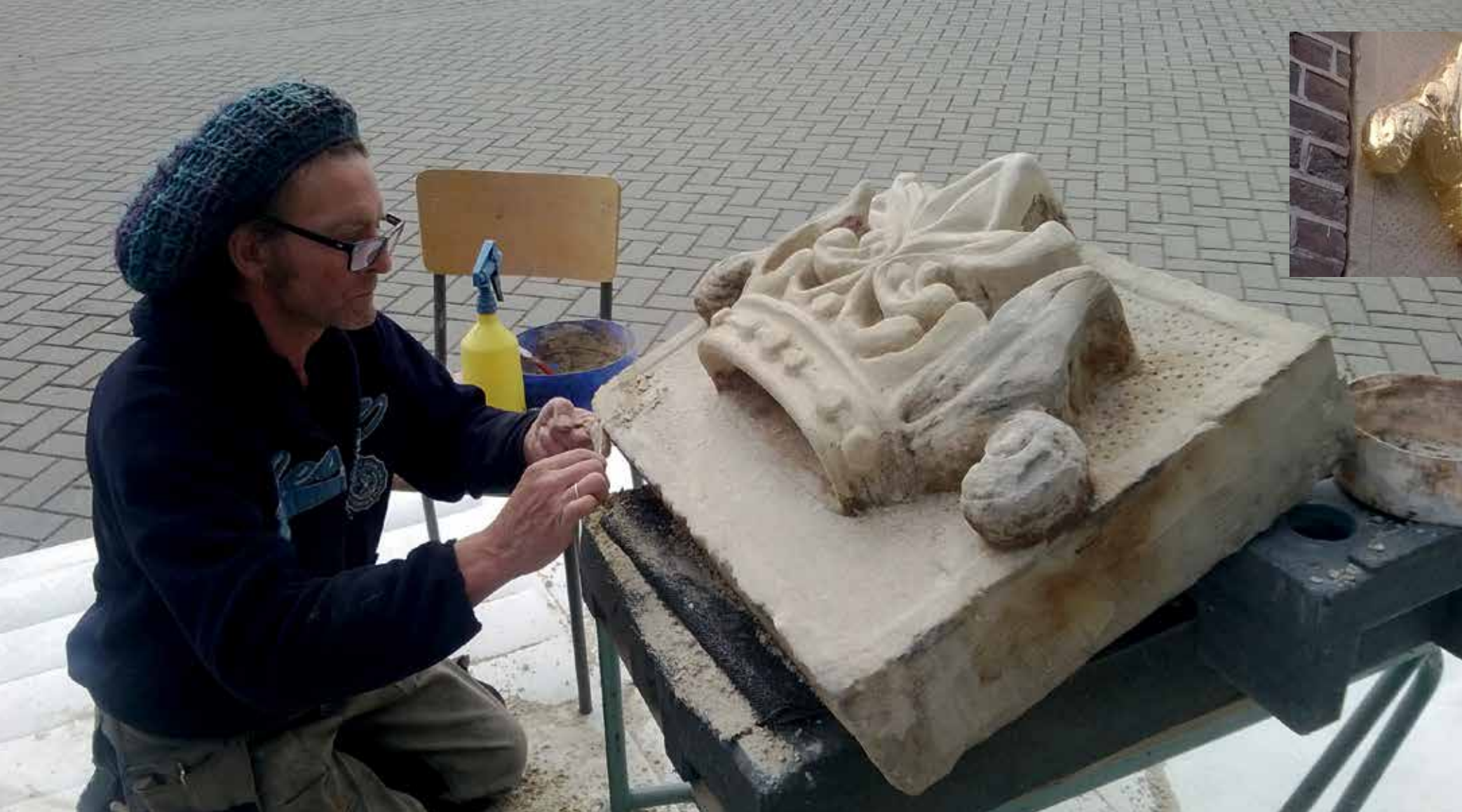
Gewelsteen in restauratie; met reparatiemortel wordt het model hersteld.
