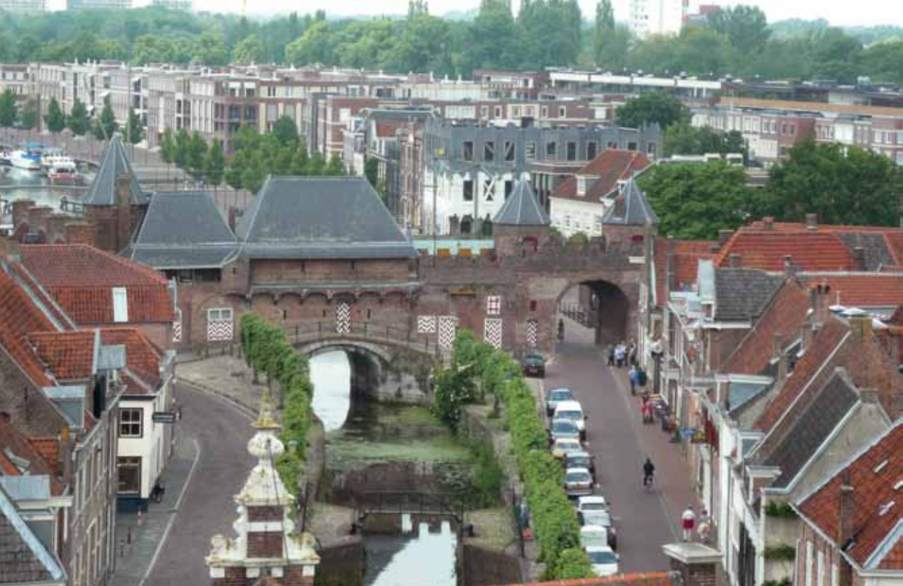
Koppelpoort vanuit de stad gezien.
