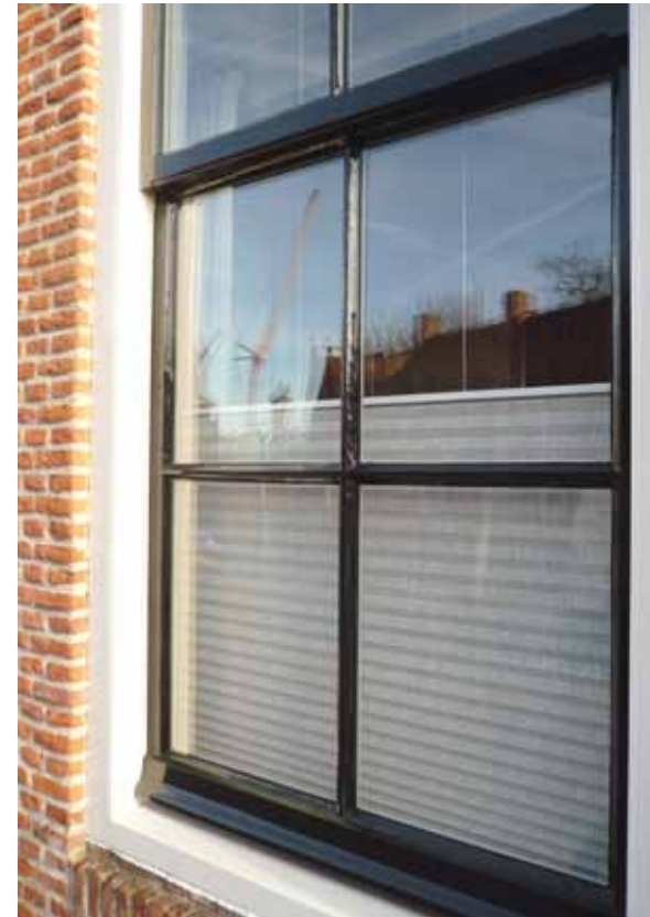
Pilot project 'Duurzaam Erfgoed', Grote Spui 17, inpassing dunne isolerende beglazing.
