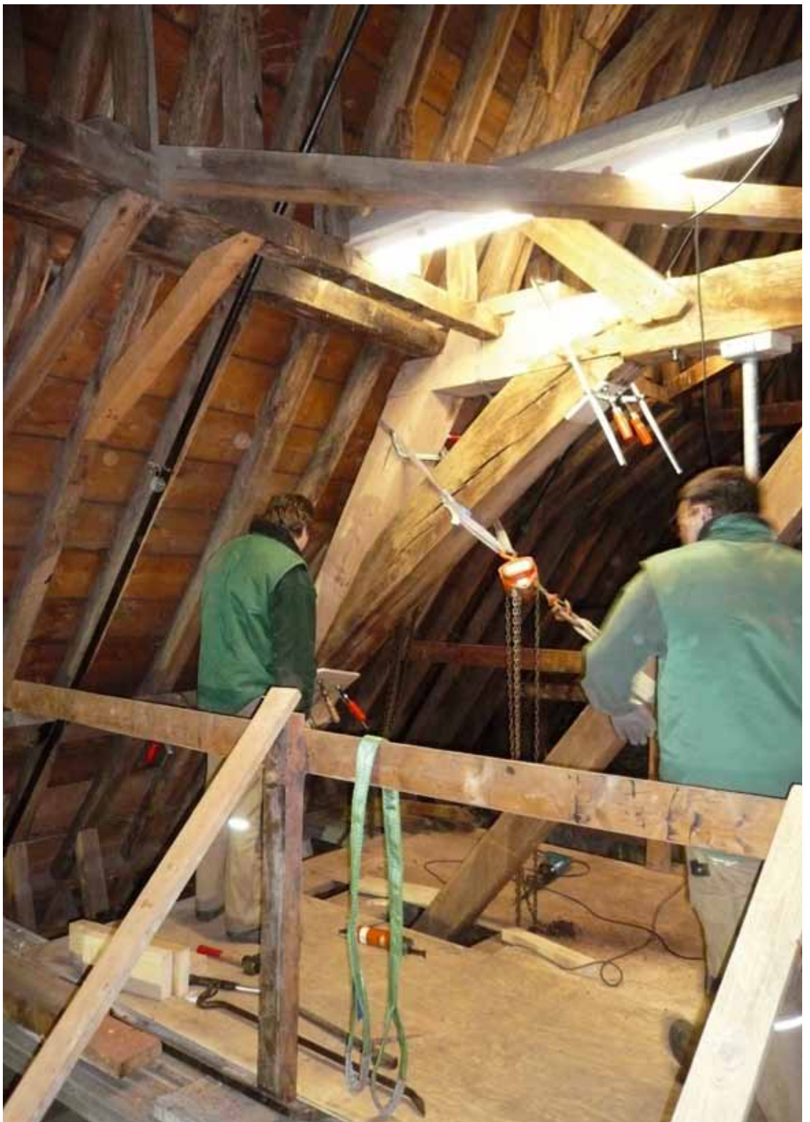
Restauratie van de kapconstructie Sint Joriskerk.
