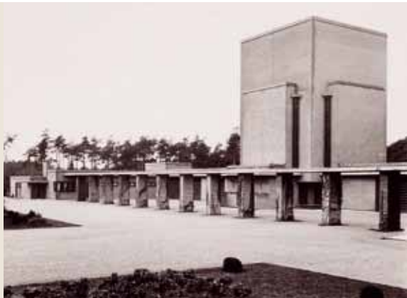
Het aulagebouw met pergola en dienstwoning in de jaren dertig. De hoekvensterpartijen in de aula zijn hier goed op te herkennen.
